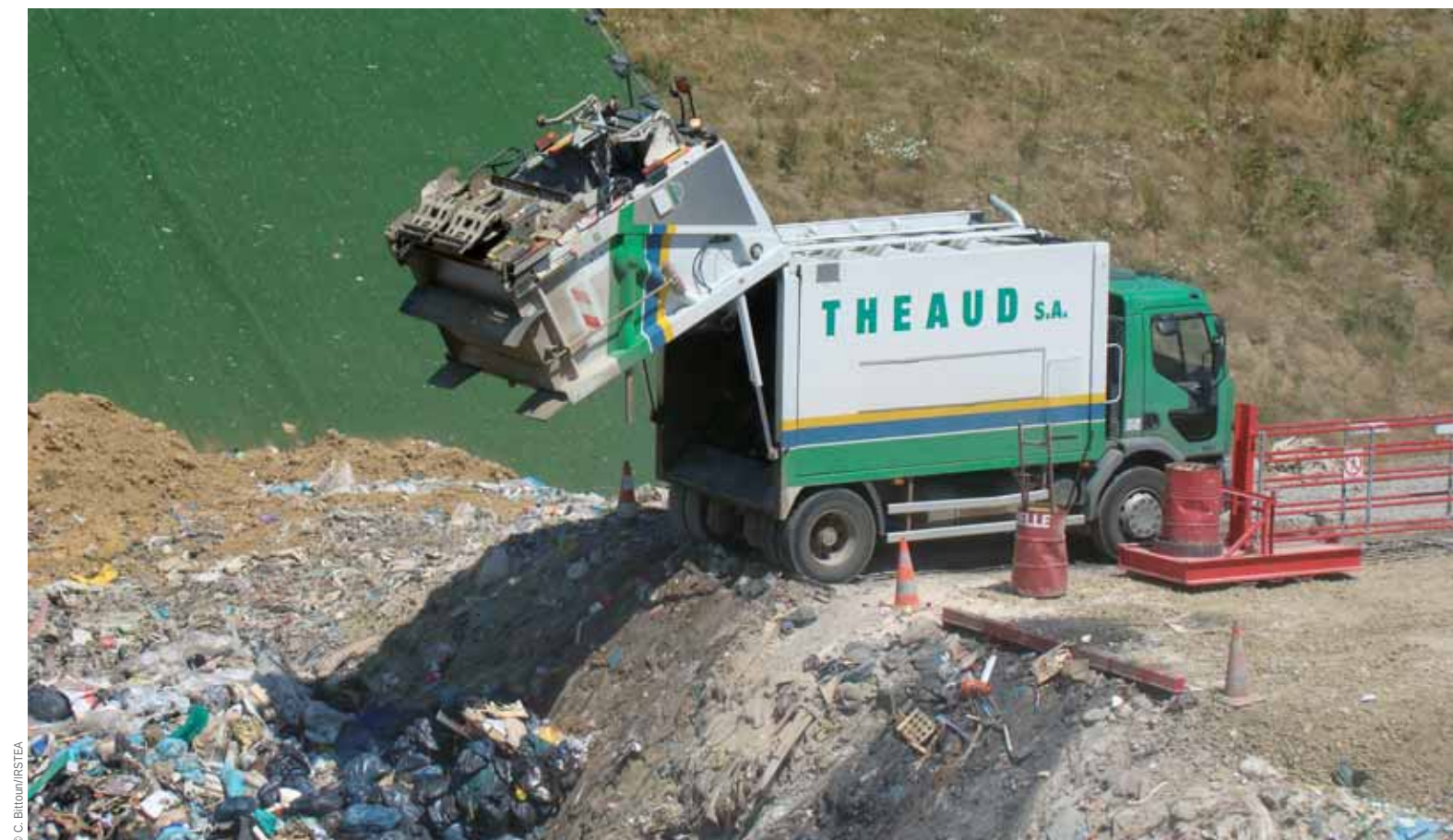
Centre de stockage de déchets ménagers exploité en mode bioréacteur, à Cuves (Manche).
