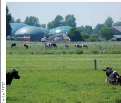
Usine de méthanisation en Allemagne.
